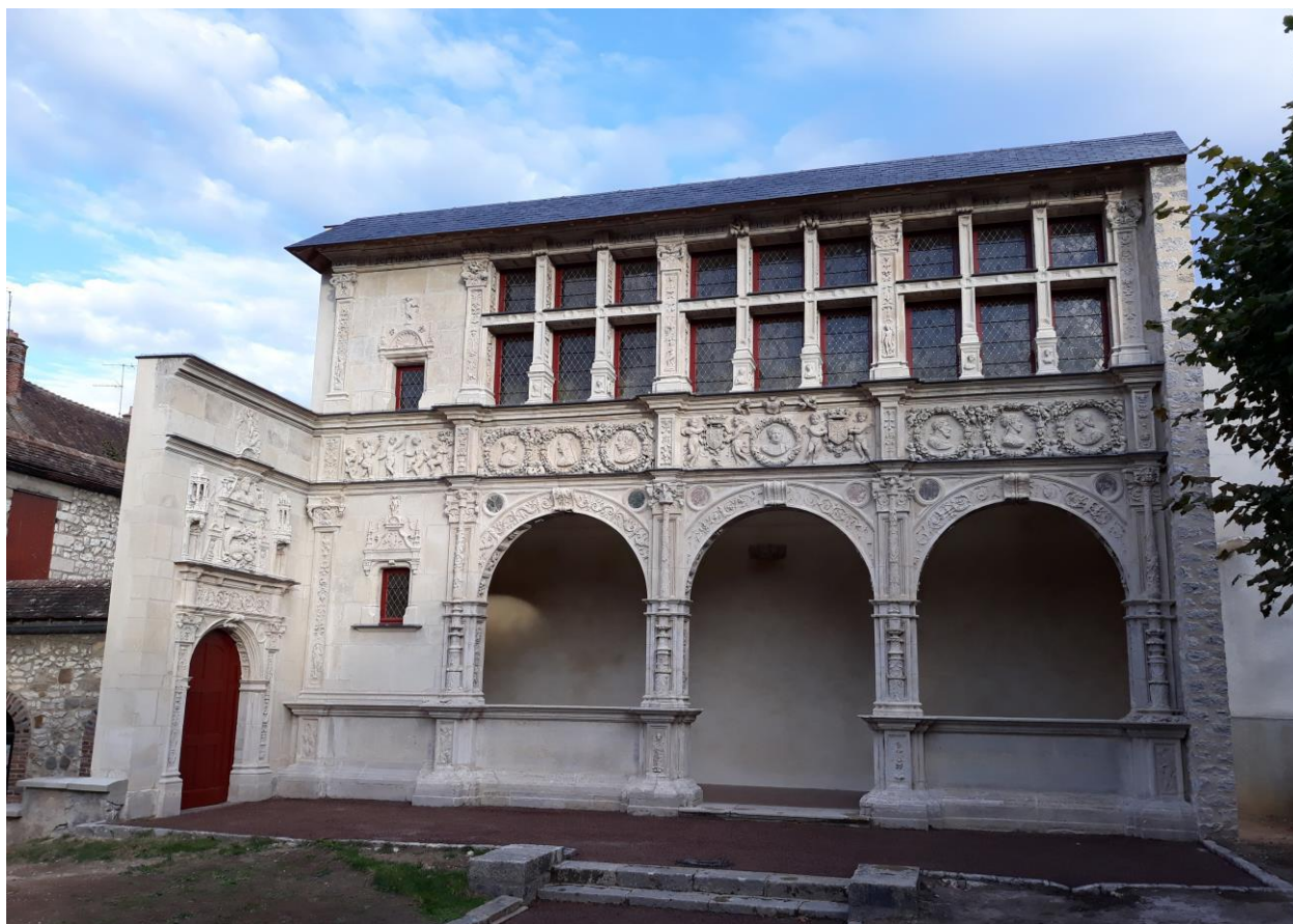
La façade François I er après restauration
